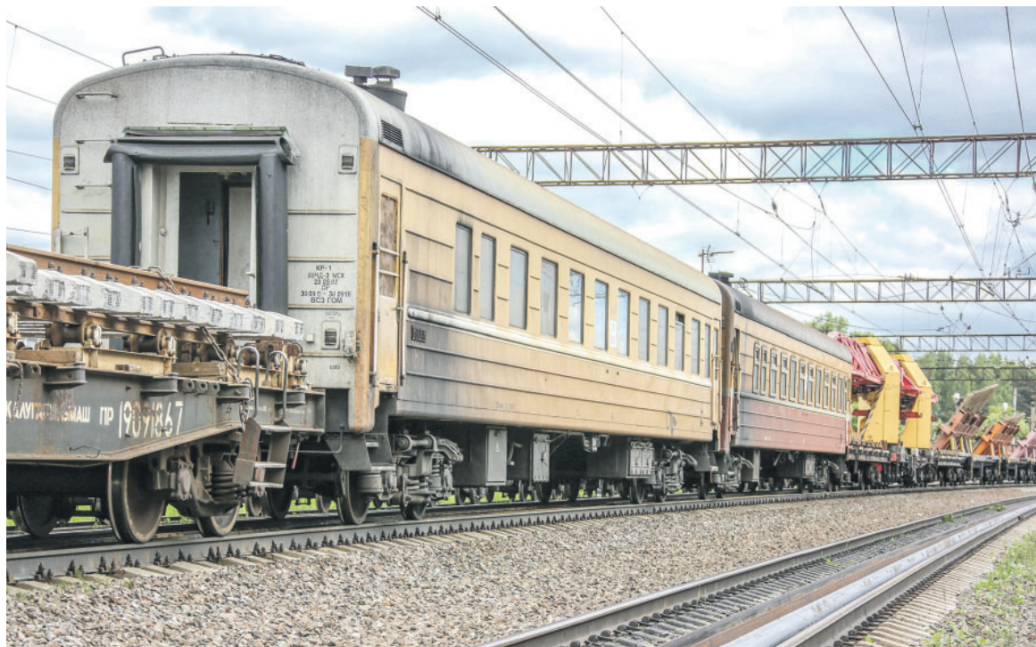
Ремонтное «окно» длится несколько суток, поэтому и условия труда должны быть достойными
